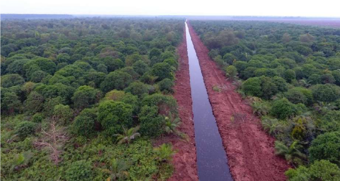
Gambar. 9. Kanal yang baru dibuat oleh PT RAPP/APRIL Group ukuran lebar 4 meter panjang lebih dari 2 KM dengan kedalaman lebih dari 2 meter.
